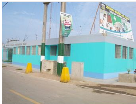
Figura N° 3.3.7.5.C-1 Centro de Salud “Ventanilla Baja” en el AH V. Raúl Haya De la Torre
