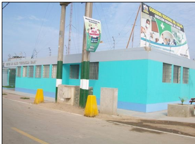
Foto N° 3.3.7.6.B-2 Centro de Salud “Ventanilla Baja”
