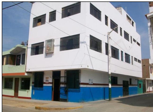
Foto N° 3.3.7.6.B-5 I.E. Harry Sullivan del AH Víctor Raúl Haya de la Torre
