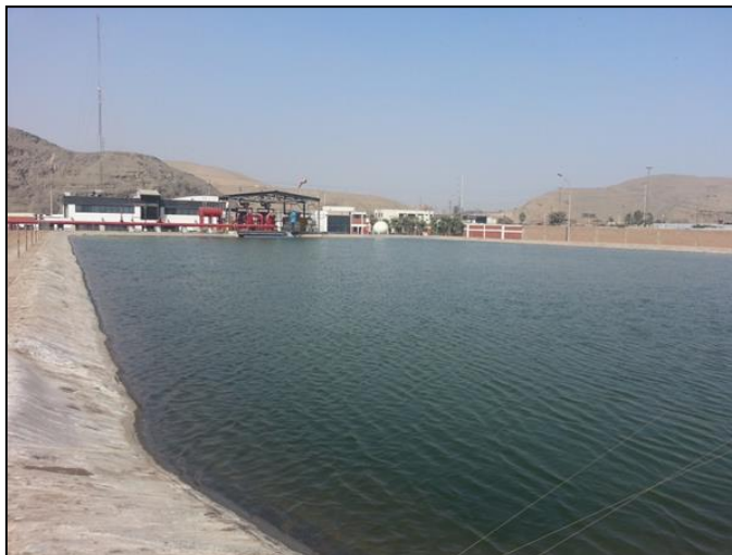
Foto N° 5.2.2.3.B-2. Piscina de agua Sistema contra incendio
