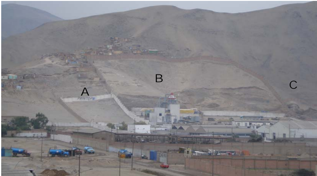
Zona Industrial de la Ciudad Satélite de Ventanilla Lote A, B y C
