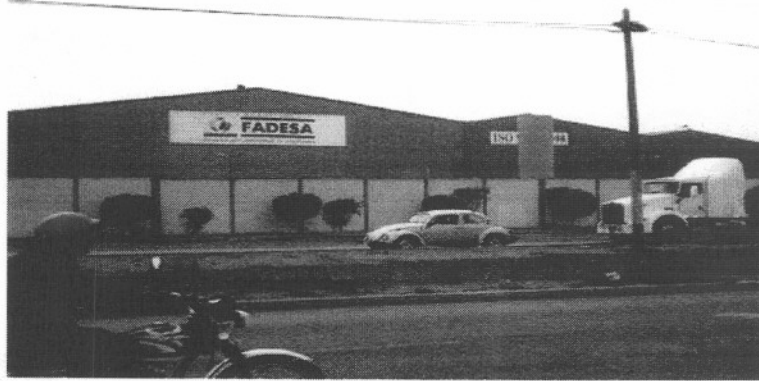
VISTA DEL DEL FRENTE TERRENO
