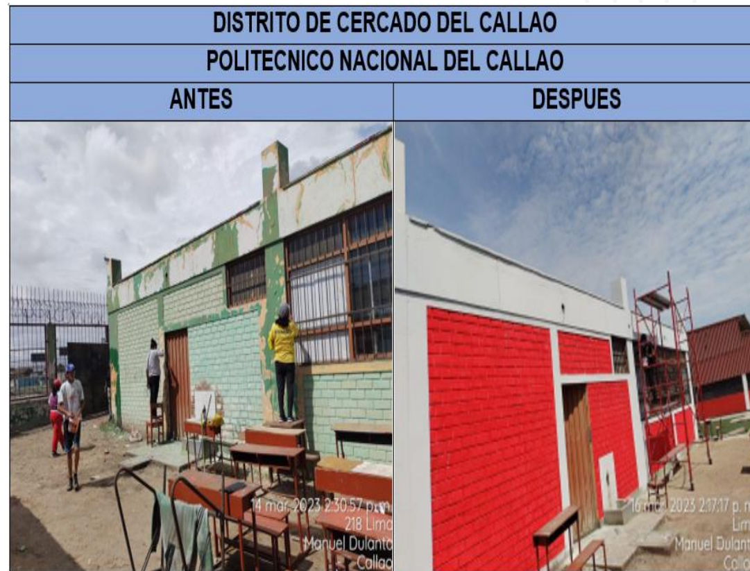
LABORES DE MANTENIMIENTO
