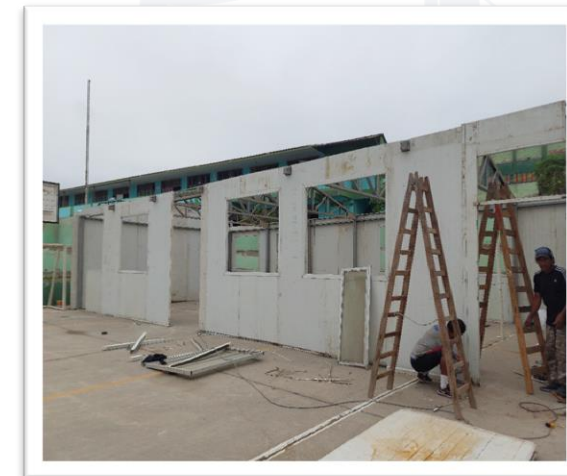
Armado de los módulos educativos prefabricados
