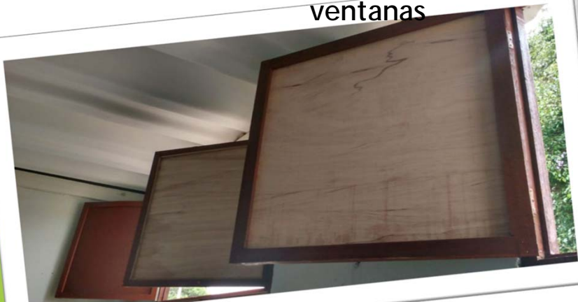
Instalación de ventanas
