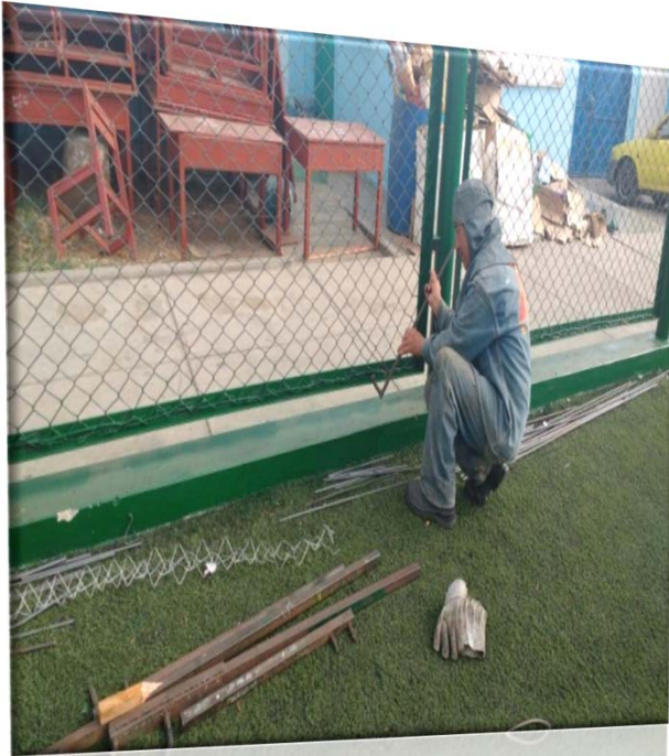
Colocación de mallas nuevas
