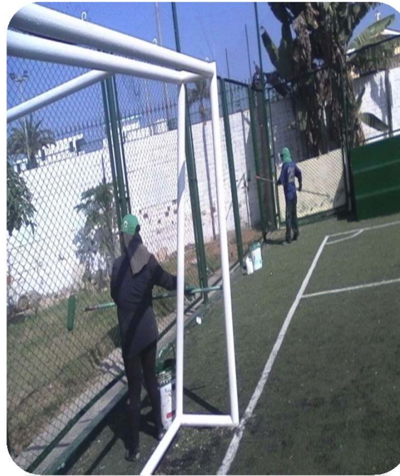
Pintado de mallas metálicas
