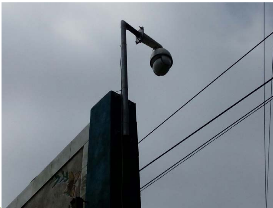
INSTALACIÓN DE CÁMARA EN EXTERIOR DE II. EE. PÚBLICA
