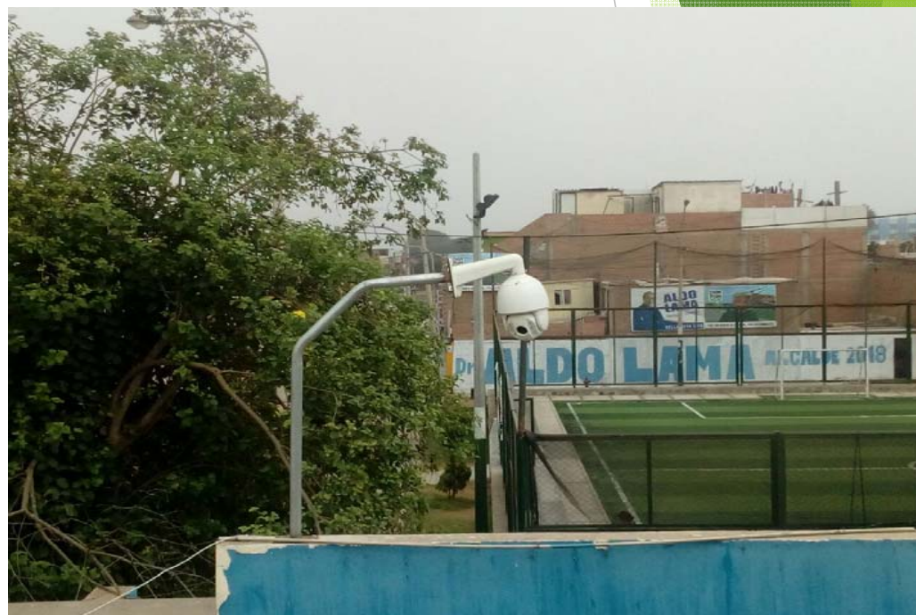
INSTALACIÓN DE CÁMARA EN EXTERIOR DE II. EE. PÚBLICA
