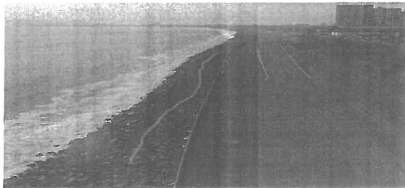
Figura 4. Vista fotográfica de la geometría de la escollera que no ha sido cubierto por canto rodado (altura del viaducto Santa Rosa)
