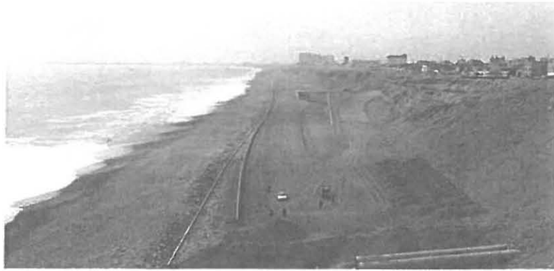
Figura 3. Vista fotográfica del estado en que se encuentra la escollera en lado sur (progresiva 4+800)
