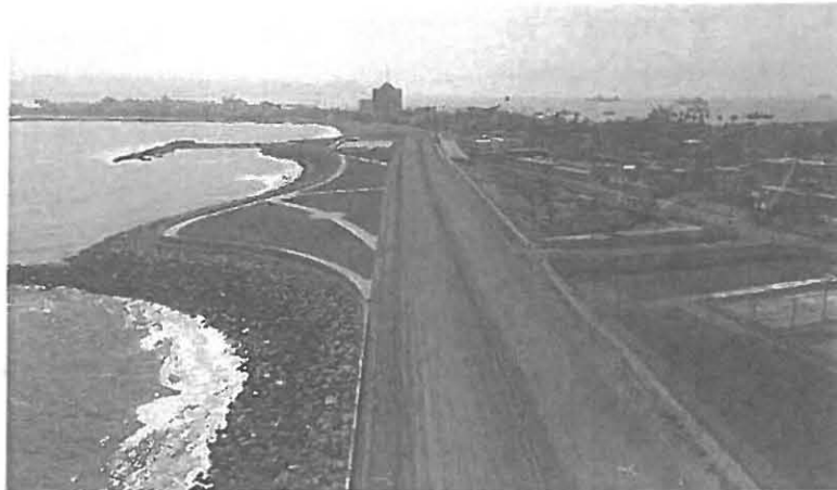
Figura 9. Construcción de rompeolas paralelos para crear playas artificiales aptas para bañistas y como defensa de costa (foto: playa Carpayo).
