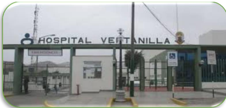
U.E. 403 HOSPITAL DE VENTANILLA
