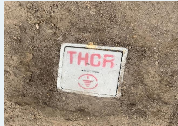
DESPUES: CAMBIO DE CAJA DE POZO A TIERRA
