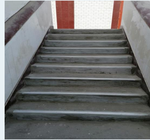
DESPUES: Resane y colocación de esquineros
