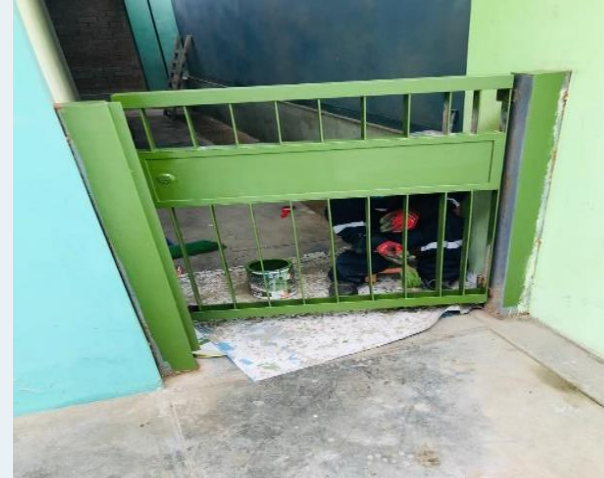
Foto Después: aplicación de base anticorrosiva en estructuras metálicas
