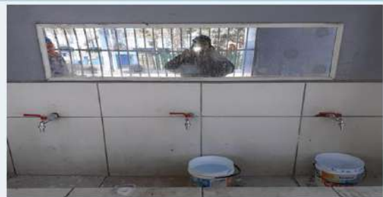
DESPUES: Cambios de caños
