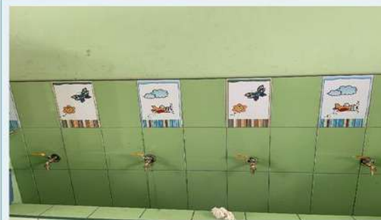
DESPUES: Instalaciones de griferías
