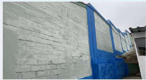
Después: rasqueteo, aplicación de sellador y pintado de muros
