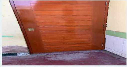
Después: Cambio de puerta de madera
