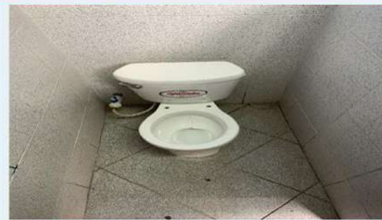
DESPUES: Instalaciones Sanitarias, cambio de inodoros completos.
