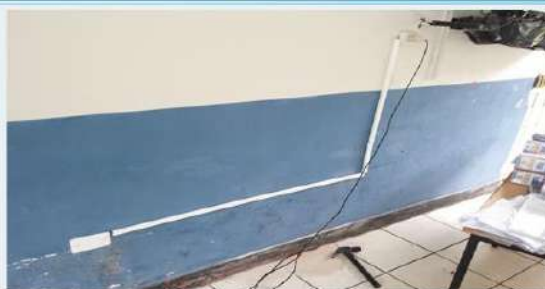
DESPUES: Instalación de canaletas
