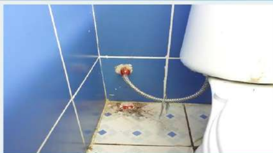
DESPUES: Instalación de tubo de abasto
