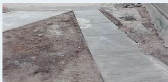
ANTES: Jardinera en mal estado
