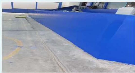
DESPUES: Resane y pintado de estrado
