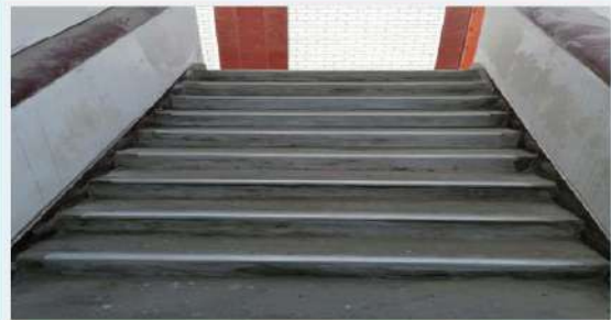
DESPUES: Resane y colocación de esquineros
