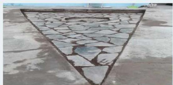
DESPUES: Reutilización de demolición en jardineras
