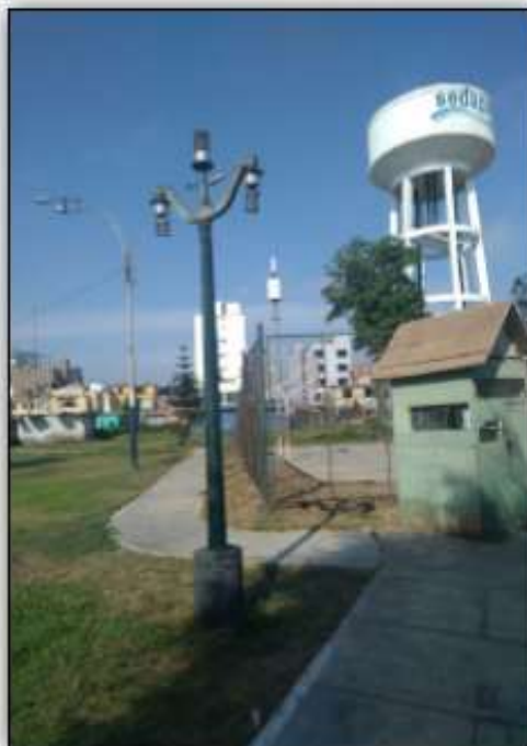
Figura N° 8 Escasa iluminación, Loza del Parque La Amistad
