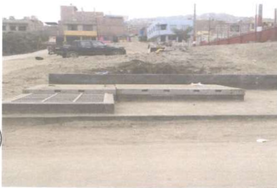
CAMARA DE BOMBEO EXISTENTE EN TERRENO DEL PARQUE SECTOR J
